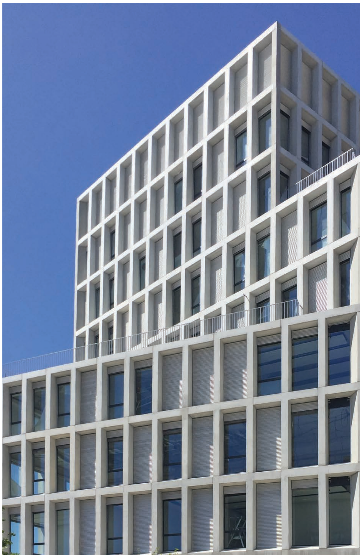
Exosquelette, préfabrication, circuit court de fabrication (chantier MAI 2019)
